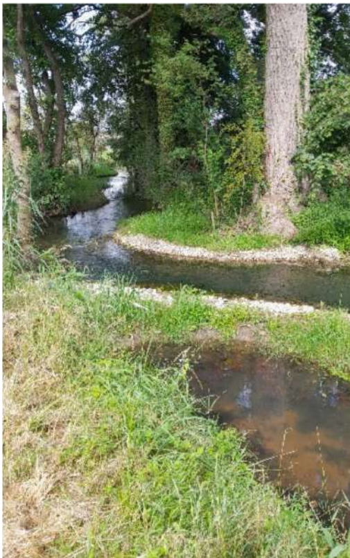
Réaménagement du Hanfgraben avec la création d'une petite annexe hydraulique
