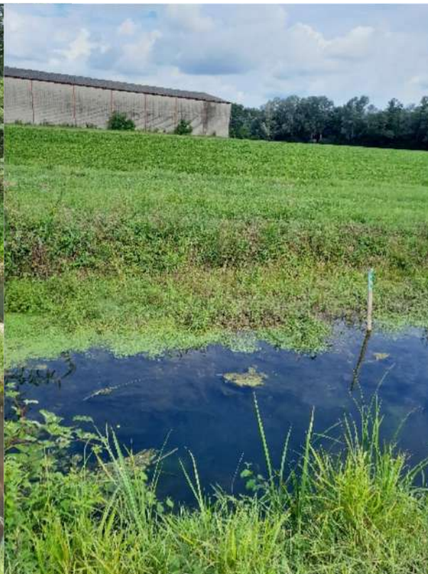
Réaménagement du Hanfgraben avec création de banquettes submergées
