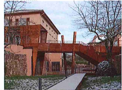
Exemple de traitement architectural en diagonal (acier corten) - secteur ABF Rénovation du groupe scolaire de Dambach-La-Ville Locus Architectes
