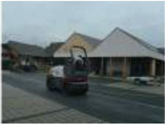
À Hipsheim, un parking de 14 places en dépose minute a été aménagé, la rue du Presbytère n'étant pas propice au stationnement. Photo Jean-Paul Kaiser
